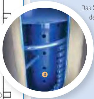
Das Steigrohr im unteren Bereich des Zonen-Schichtspeichers führt das Speicherwasser beruhigt in die entsprechenden Wärmeschichten ein
